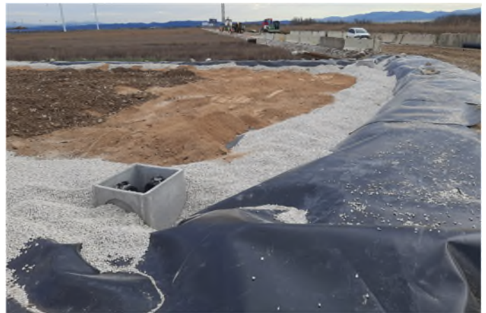
Figura 16 – Esempio di fasi realizzative di preparazione dell'area di deposito del materiale di scavo microtunnel: a sinistra, posa dei tubi drenanti di raccolta e convogliamento acque; a destra, posa pozzetti e riempimento con materiale drenante attorno al tubo drenante
