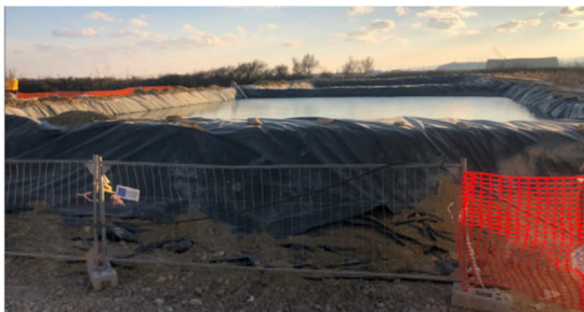
Figura 18 – Esempio di vasca fluidi di perforazione impermeabilizzata con telo unico
