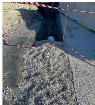
Figura 12 – Esempio di fasi realizzative di preparazione dell'area di deposito del materiale di scavo microtunnel: a sinistra, fase prima del getto soletta con predisposizione HDPE per impermeabilizzazione della futura canaletta di raccolta e convogliamento acque; a destra, riempimento con materiale drenante attorno al tubo drenante
