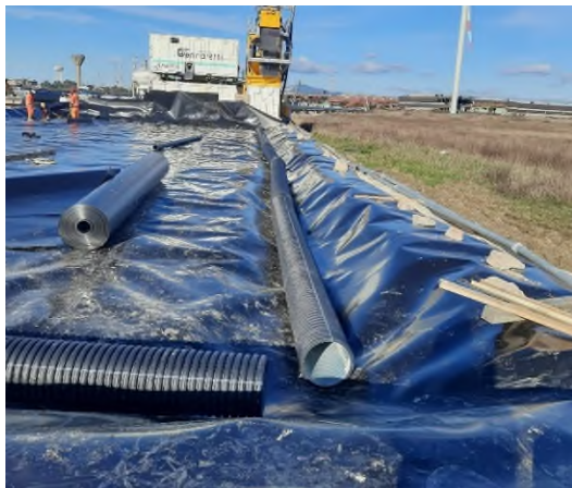
Figura 16 – Esempio di fasi realizzative di preparazione dell'area di deposito del materiale di scavo microtunnel: a sinistra, posa dei tubi drenanti di raccolta e convogliamento acque; a destra, posa pozzetti e riempimento con materiale drenante attorno al tubo drenante
